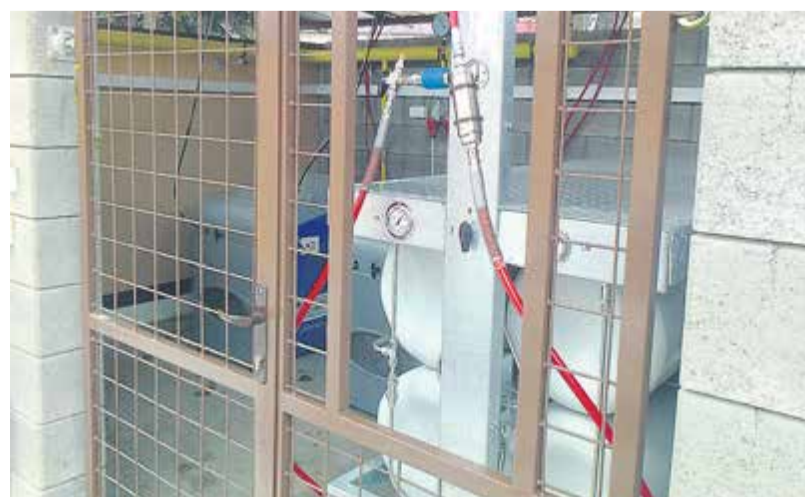
Rozvoz pečiva zajišťuje slovenská Pekárna Jackulík pětici fiatů, které od konce loňského tankují CNG z plnicí MJ Variant 2K, kterou naprojektovala a dodala MOTOR JIKOV Strojírenská a.s.
