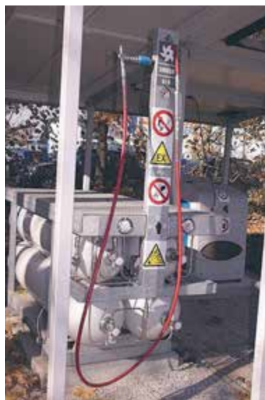
Plnicí stanice MJ Variant 1k – 560 l ve slovinském městě Kranj je složena z plnicí stanice MJ Compact 05 o výkonu 5 m 3 /h a vysokotlakého zásobníku o objemu 560 l
