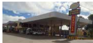
Vozů na CNG jezdí v Bolívii přes tři sta tisíc, čemuž odpovídá i velikost plnicích stanic.
