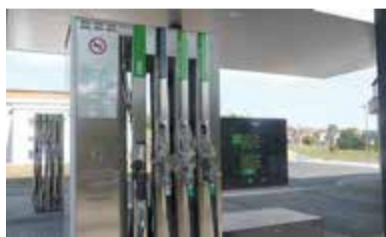
Poprvé v České republice byl použit multiproduktový výdejní stojan, který umožňuje čerpání nejen CNG ale i benzínu a nafty.
