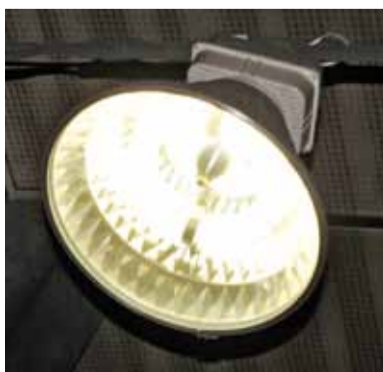
Indukční lampy se vyznačují nízkou spotřebou energie a vyšší kvalitou světla
