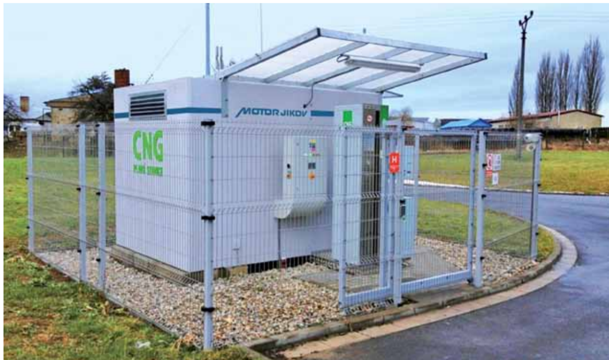
Plnicí stanice MJ Compact Plus s výdejním stojanem (ilustrační foto)
