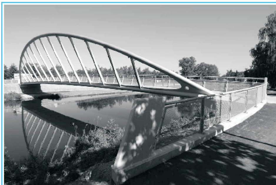
Stavba roku: Lávka pro pěší a cyklisty
