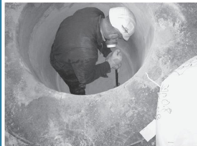
Pracovník dodavatelské firmy ALLIED MINERAL provádějící přípravu vyzdívky pece
