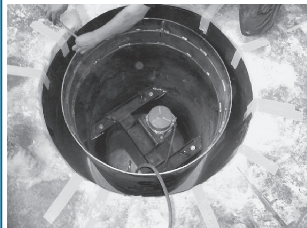
Vibrační motor usazený v šabloně pro zhutnění vyzdívky
