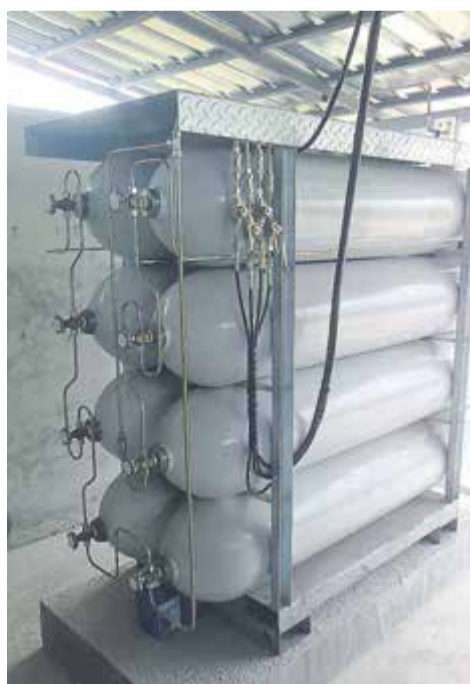
Rumunsko je z pohledu CNG takřka nepopsanou deskou. K rozšíření alternativního paliva pomůže i nově postavená plnicí stanice MJ Variant 4K se zásobníkem plynu na 1120 litrů.
