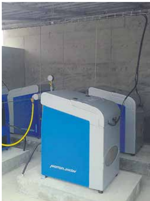
Rumunsko je z pohledu CNG takřka nepopsanou deskou. K rozšíření alternativního paliva pomůže i nově postavená plnicí stanice MJ Variant 4K se zásobníkem plynu na 1120 litrů.
