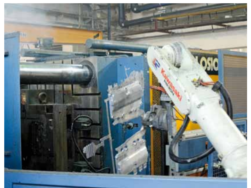
Vysokotlaký licí stroj COLOSIO s uzavírací silou 1000 tun s robotem a ostřihovacím lisem tvoří robotizovanou výrobní jednotku. Jde o největší jednorázovou investici loňského roku. Stroj je využíván také při výrobě dílů předního a zadního krytu pro alternátor desáté generace pro zákazníka Mitsubishi.
