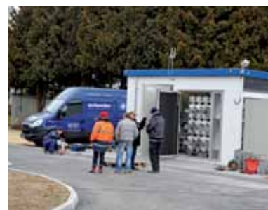
Instalace kontejneru s technologií CNG
