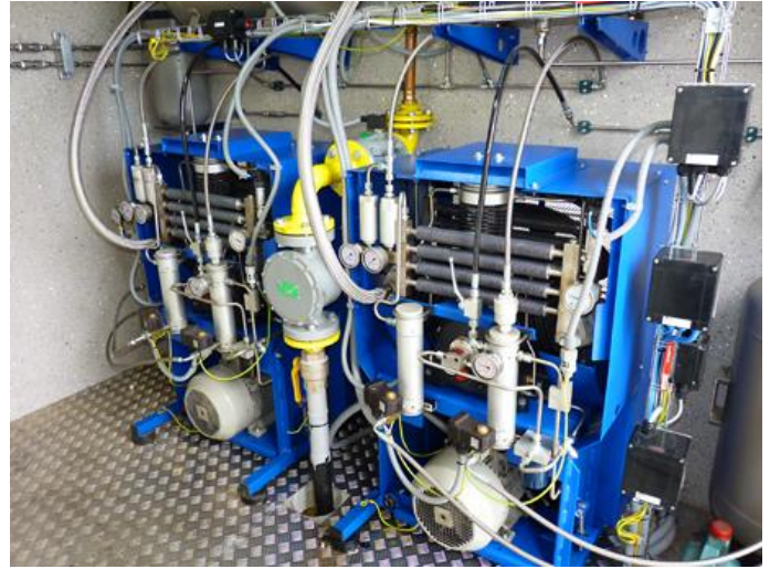
Kompresorové jednotky uvnitř stanice MJ Compact Plus
