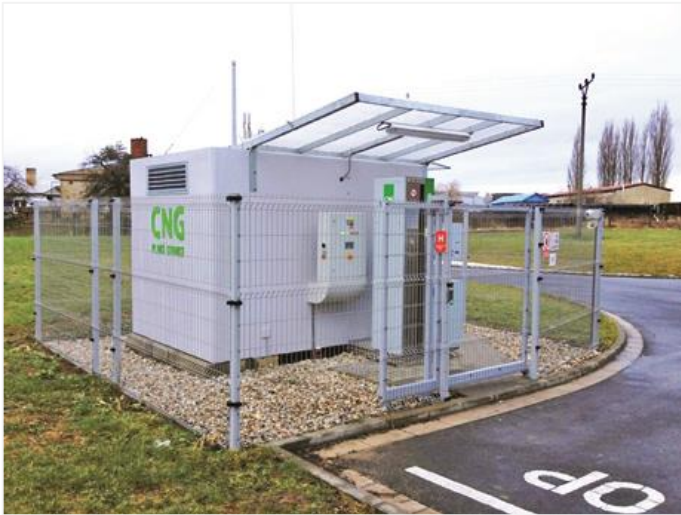
Plnicí stanice MJ Compact Plus s výdejním stojanem (ilustrační foto)
