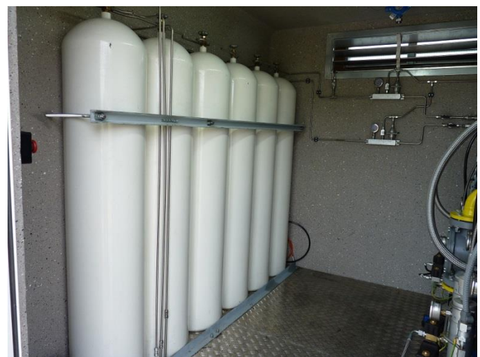
Tlakový zásobník uvnitř jednotky
