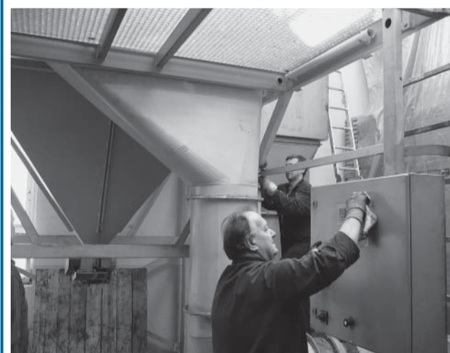
Pracovníci firem KMA, GmbH a MOTOR JIKOV Tlaková slévárna a.s. instalují nové filtrační zařízení.
